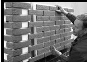
Wenn Sie sich jetzt für den Haacke IsolierKlinker entscheiden, bekommen Sie den Energiepass gratis dazu. Verklinkerung und Wärmedämmung aus einer Hand.
